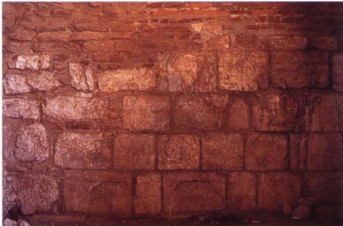
Muratura di stratificazione risalente all'impianto del II sec. d.C. La superficie litica, appartenente all'impianto greco, annerita in modo quasi omogeneo, è compromessa da vistose fratture e scheggiature.
