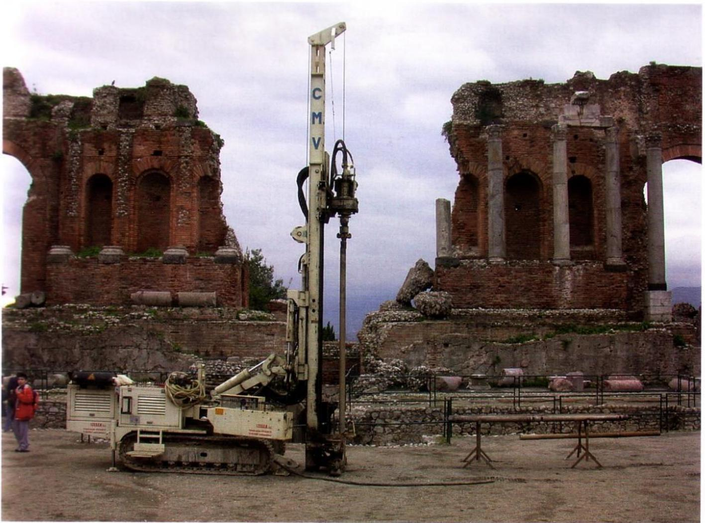
Fig. 3 - Sondaggio interno: carotatore
