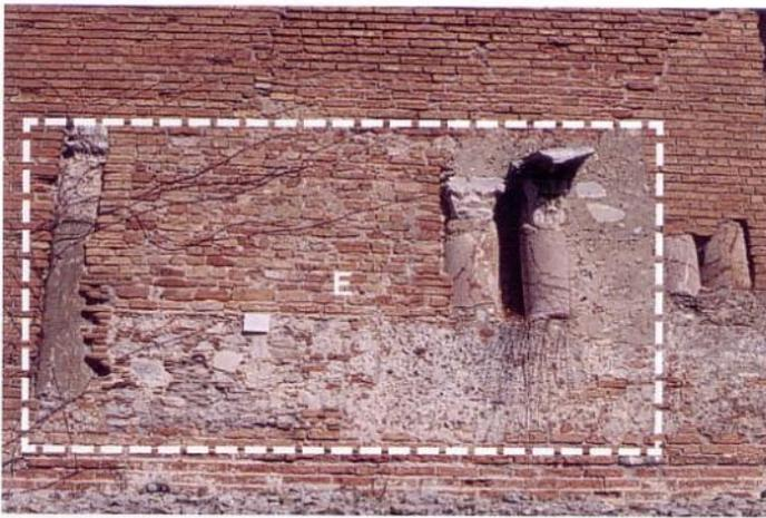
*In basso a sinistra:* assemblaggio anomalo con malta cementizia di un fusto di colonna e di un frammento di cornice.
