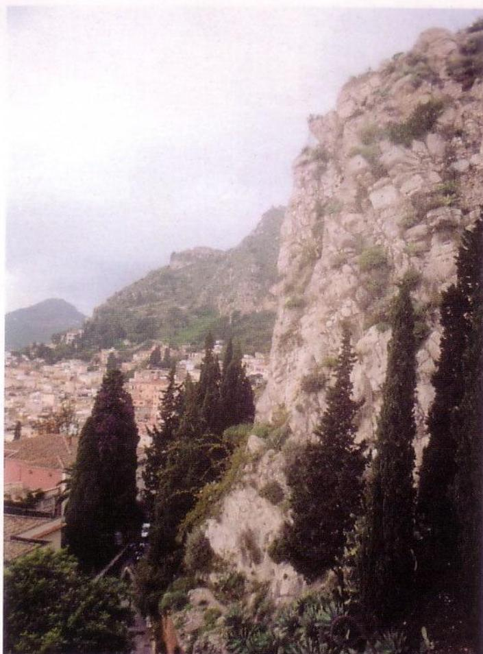
Foto 5 - Vista della parete rocciosa nord-ovest incombente sulla strada di accesso al Teatro. Si riconosce un grosso blocco a forma di pinnacolo in equilibrio instabile
