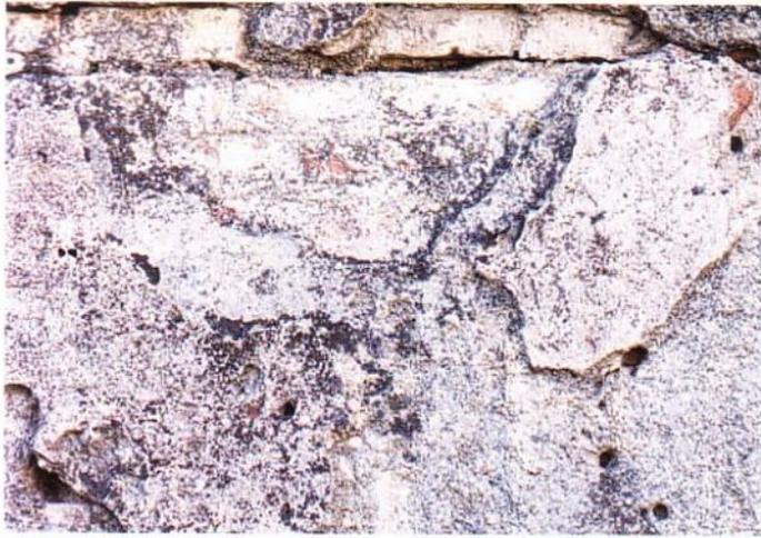
La muratura presenta soluzioni di continuità, oltre a vistosi annerimenti diffusi ed il distacco con perdita totale degli strati di intonaco.
