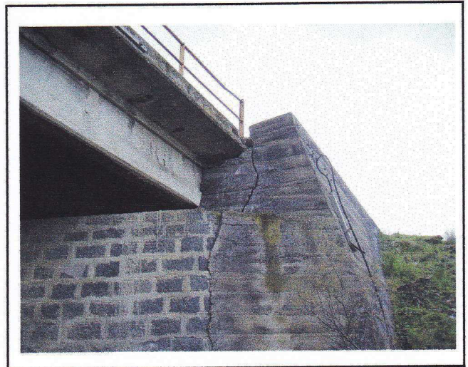
Ponte Pietralunga spalla destra
