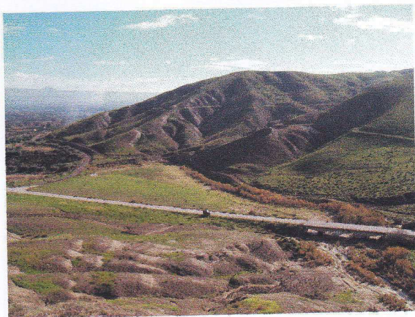
S. P. 50 Ponte sul Torrente Cannizzola
