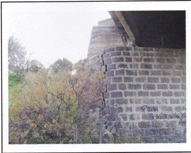
Ponte Pietralunga spalla destra
