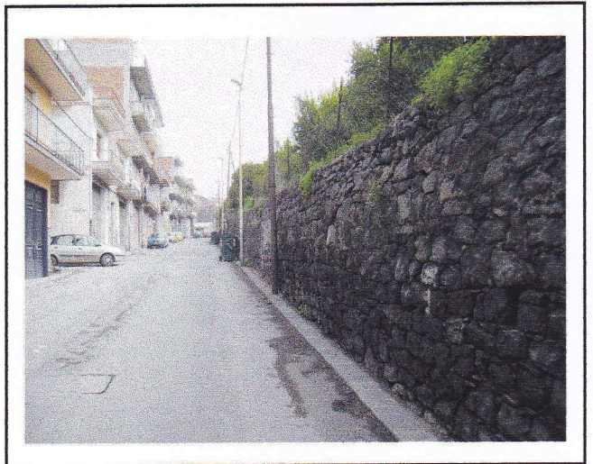
Via S. Marco muro di contenimento
