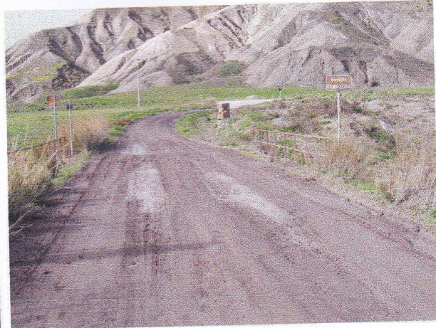
S. P. 228 Ponte sul Torrente Cannizzola
